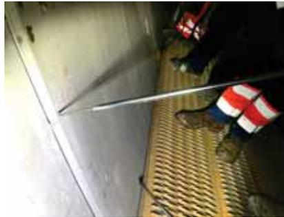
Bild 2: Injektionsbohrnadel (1) und Injektionsrohr (2) als Werkzeuge für die gezielte Fugennachdichtung.
