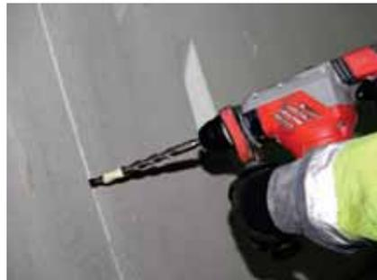
Bild 1: Aufbohren einer Tübbingfuge mit einem 18 mm Betonbohrer.
