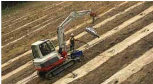
Bild 4: Gesicherter Minibagger beim Ankerspannen (im Bild gut erkennbar sind die ursprünglichen Anker sowie die im Zuge der Sanierung eingebauten Zusatzanker).
