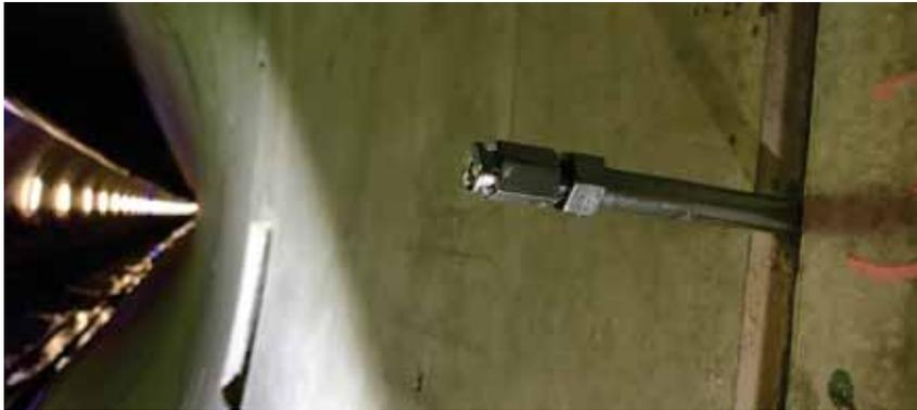
Bei Erfordernis von Nachdichtungsinjektionen ist die gezielte Fugennachdichtung durch die Tübbingdichtung hindurch eine effektive und Kosten ersparende Alternative zu den aufwendigen Betonbohrungen, die üblicherweise für die Nachdichtungsarbeiten hergestellt werden müssen. Wir konnten bei den Nachdichtungsarbeiten an den Tübbingröhren des Finnetunnels erste positive Erfahrungen bei der Umsetzung dieses - zum damaligen Zeitpunkt - innovativen und neuartigen Verfahrens machen.
