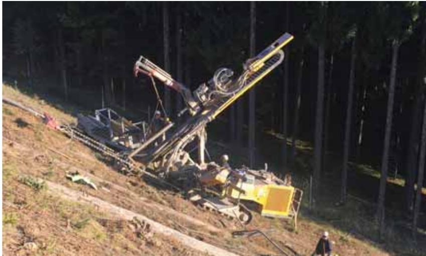
Bild 3: Bohrgerät an „Haken und Seilwinde“ sowie Arbeitsplattform für Gestänge und das „Abrollen der Anker“
