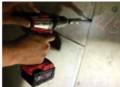
Bild 3: Eindrehen von Injektionsbohrnadel und Injektionsrohr mithilfe eines Akkuschraubers und eines Einbohraufsatzes (3).
