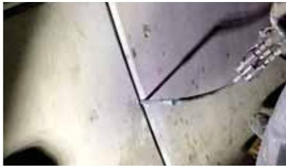
Bild 4: Injizieren in einer Tübbingringfuge mithilfe von Injektionsbohrnadel und Injektionsrohr.
